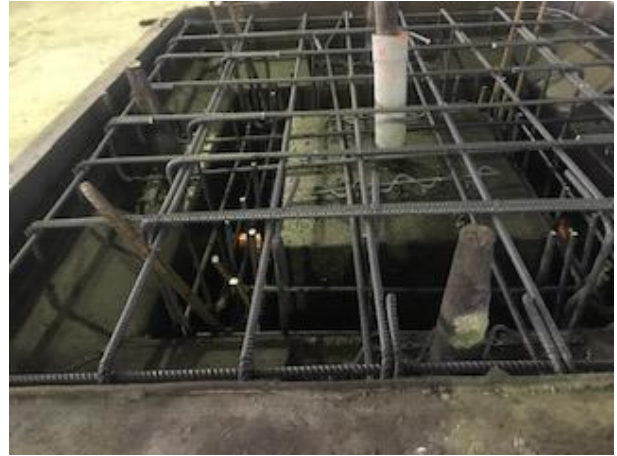
Fig. 1. Realizzazione di un plinto prefabbricato, presso l'Azienda Componenti Vibrocemento Sardegna
